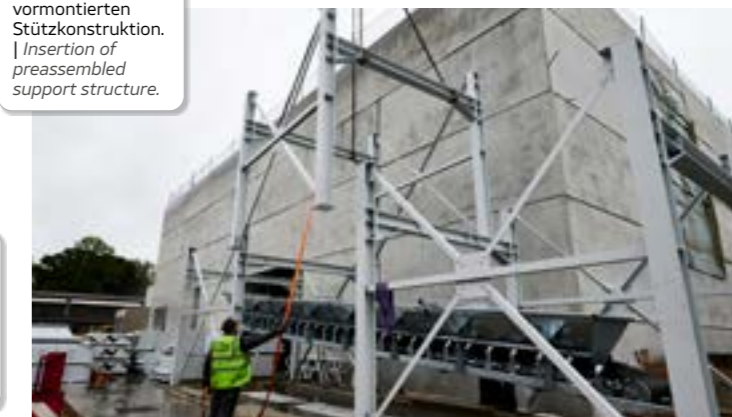
Montage der Stützkonstruktion des Zuschlagstofflagersilos. | Assembly of the support structure for the aggregate storage silo.
