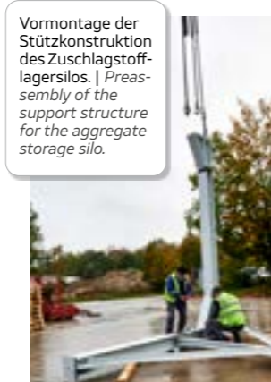
Anschluss Silostütze Zuschlagstofflagerkammer. | Connection of support column to aggregate storage silo.
