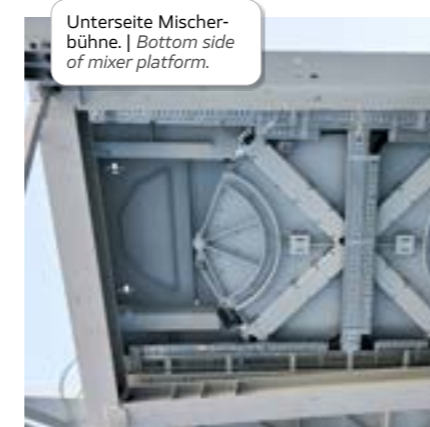
Vorbereitung zum Einheben der im Werk vollständig vormontierten Mischerbühne. | Preparation for insertion of complete, workshop-assembled mixer platform.
