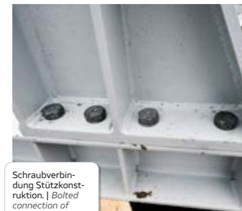
Kontrolle der Schraubverbindungen. | Check of bolted connections.
