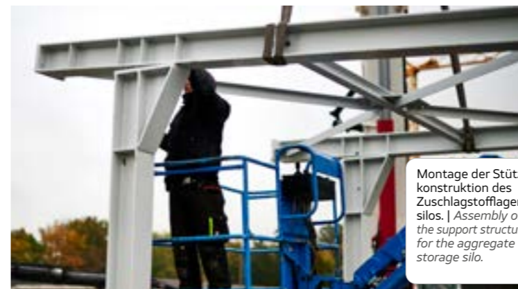
Einheben der vormontierten Stützkonstruktion. | Insertion of preassembled support structure.
