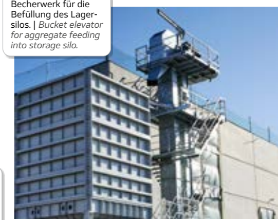
Treppenaufgang Becherwerk. | Staircase for bucket elevator.
