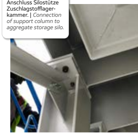
Schraubverbindung Stützkonstruktion. | Bolted connection of support structure.
